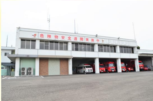
伊万里消防署庁舎に危険物 安全週間啓発パネル設置
