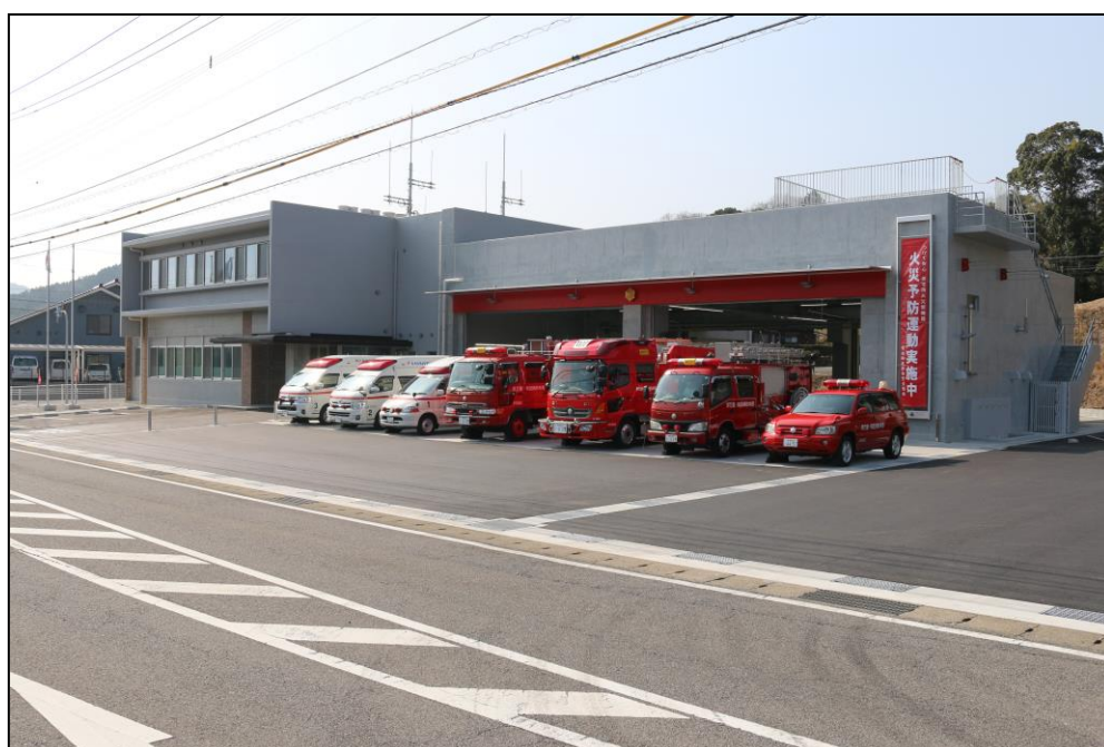
有田消防署 (令和3年3月完成)
