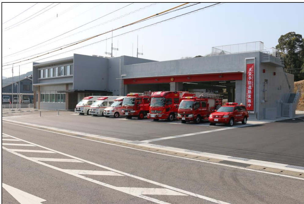
有田消防署 (令和3年3月完成)
