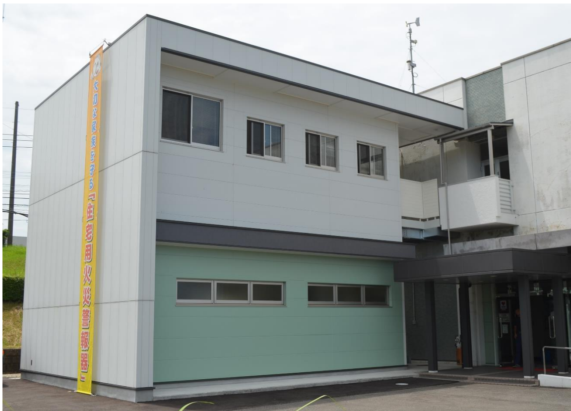
伊万里消防署増築棟
